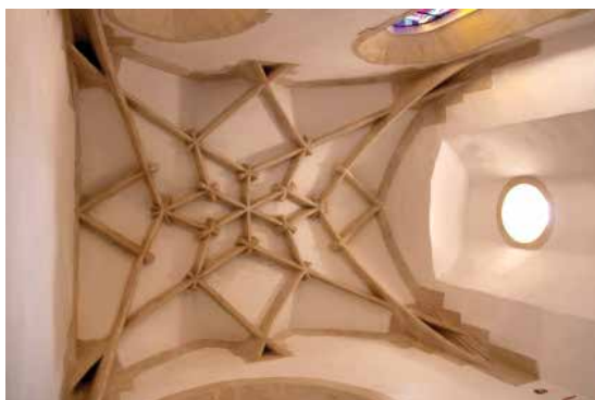
Slika 13. Izvedena rekonstrukcija gotičkoga svoda u velikoj kapeli voćinske crkve, 2011. (autor: B.V.Š.)
