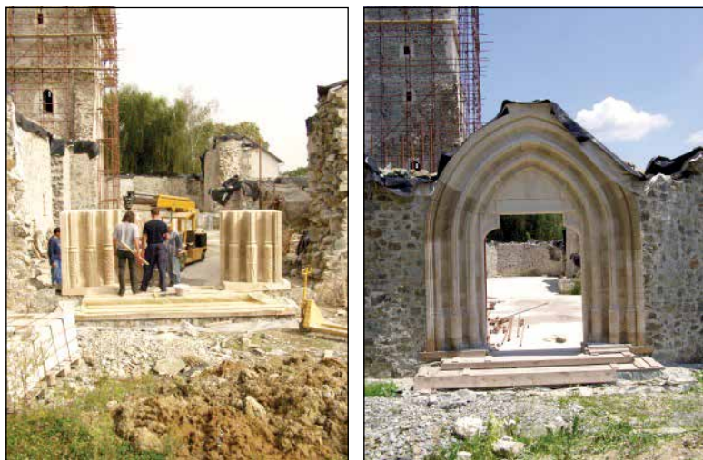
Slika 11. Postavljanje blokova glavnoga ulaznog portala, stanje – studeni 2004. i srpanj 2005. (autor: B.V-Š).
