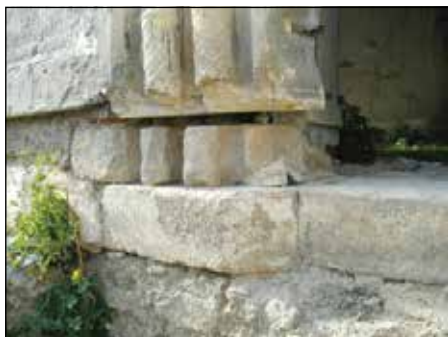
Slika 9. U slojevima poda sačuvane su baze portala koji vodi iz svetišta prema prizemlju zvonika, nekadašnjoj sakristiji, 2002. (autor: B.V-Š).
