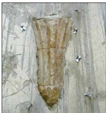
Slika 12. Sjeverozapadna peta križno-rebrastoga svoda u prizemlju zvonika nakon restauratorskoga čišćenja i snimanja, 2002. (autor: B.V.Š.)
