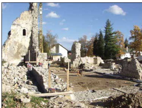
Slika 5. Početak građevinskih radova na obnovi voćinske crkve Pohođenja BDM, rujan 2002. (autor: B.V-Š).
