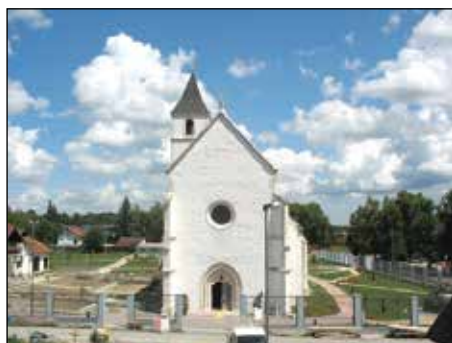
Slika 17. Fotografija iz vremena gradnje – obnove voćinske crkve Pohodeња BDM, srpanj 2011. (autor: S. Cvetnić).
