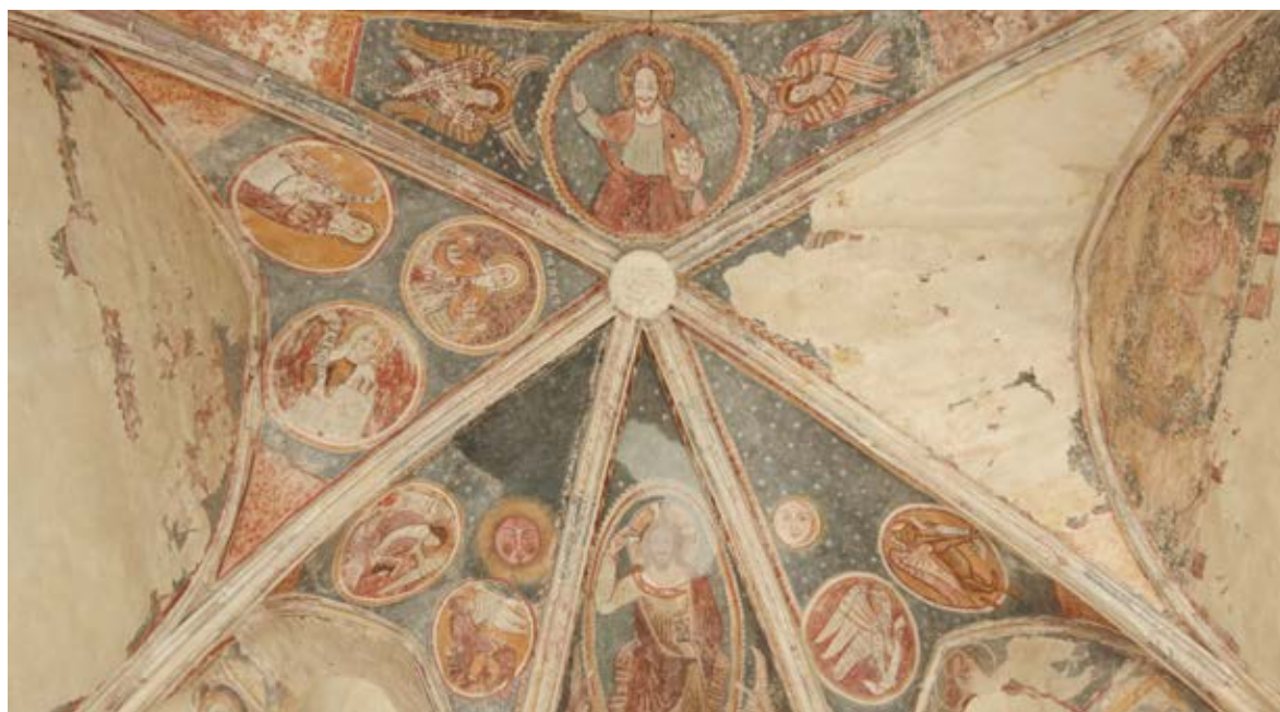
Svod svetišta crkve sv. Lovre s freskama iz 14. st.
